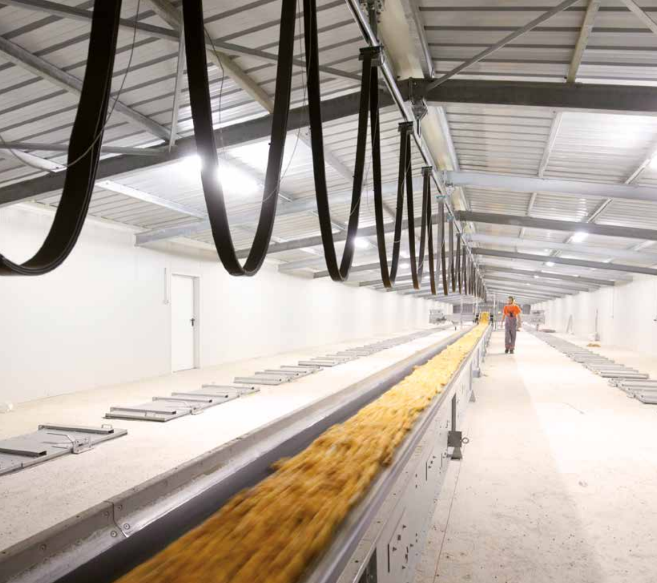
Unsere riesige Saatgutaufbereitungsanlage in Serbien wurde in diesem Geschäftsjahr nach weniger als einem Jahr Bauzeit eröffnet.
